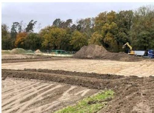
Seit letzter Woche Montag sind die Raupen und Bagger der Firma Cordel, die schon 2009 unseren ersten Kunstrasenplatz gebaut hat, im Einsatz. Zunächst wird der Mutterboden abgetragen, dann die Drainagen verlegt und das Planum aufgebaut. Dazu werden die Rigole für das Drainagewasser sowie Zisternen für die Bewässerung gebaut.
